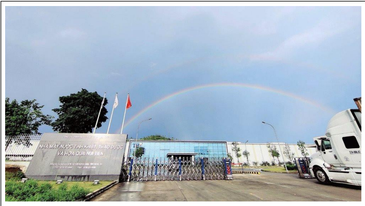
Hình 1. 14. Nhà xưởng sản xuất của cơ sở
