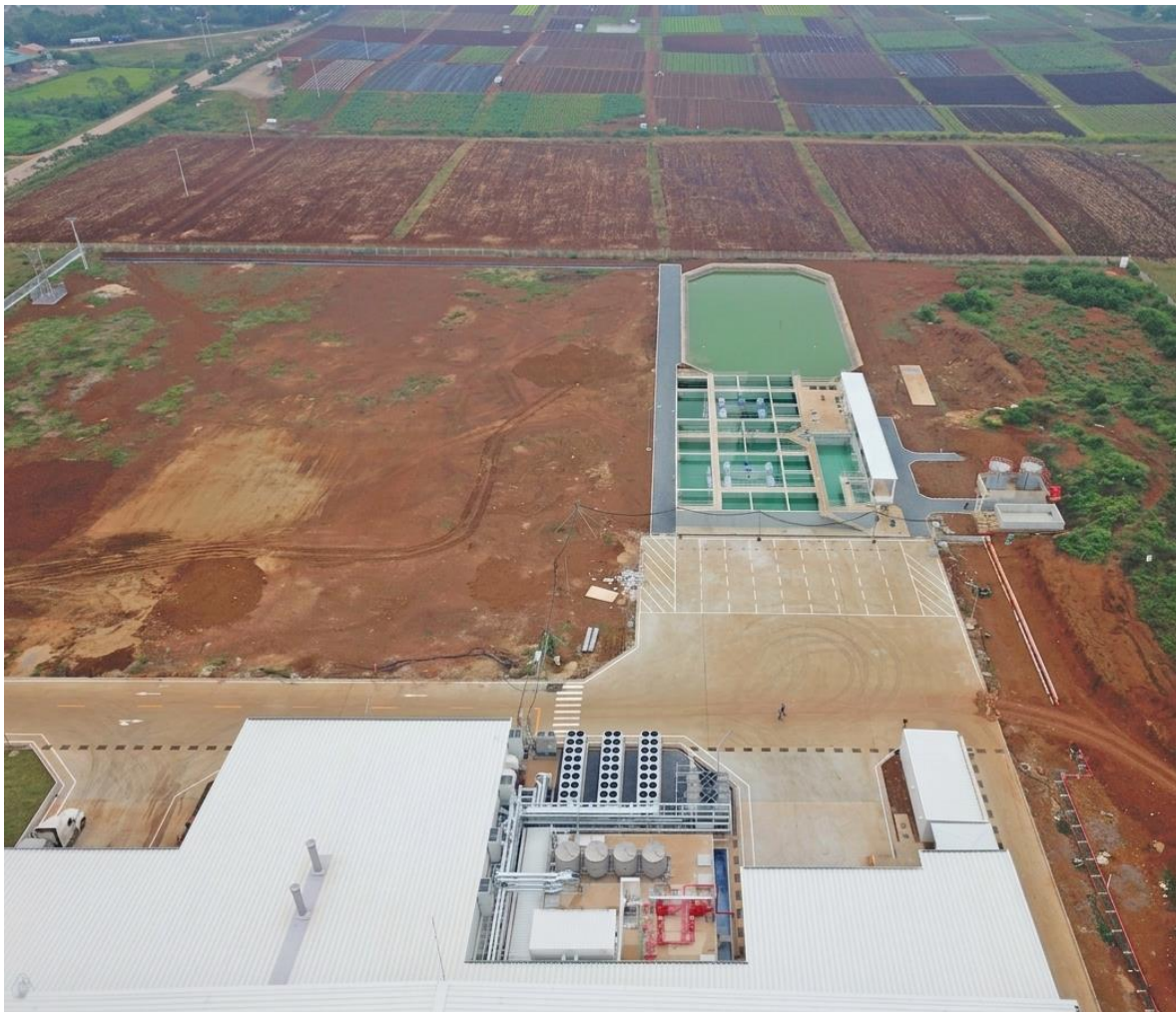
Hình 3. 7. Hệ thống xử lý nước thải tập trung công suất 1.500 m 3 /ngày
