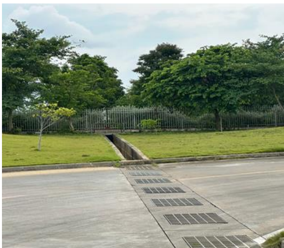
Cửa xả nước mưa số 01
